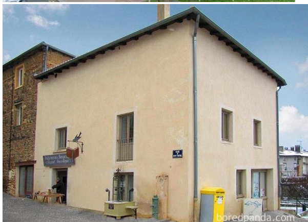
Рис. 1. Вигляд будинків до виконання проектів з художнього розпису зовнішніх стін муралами
