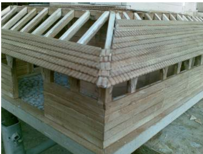
Рис. 6. Покриття даху і піддашся «гонтами» (дерев'яними дощечками)
